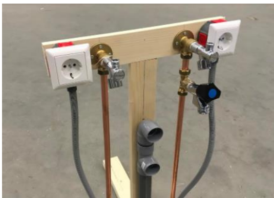
Afbeelding toont de gewenste ordelijke installatiewijze van het leidingwerk (let op: het benodigde leidingwerk is situatieafhankelijk)
